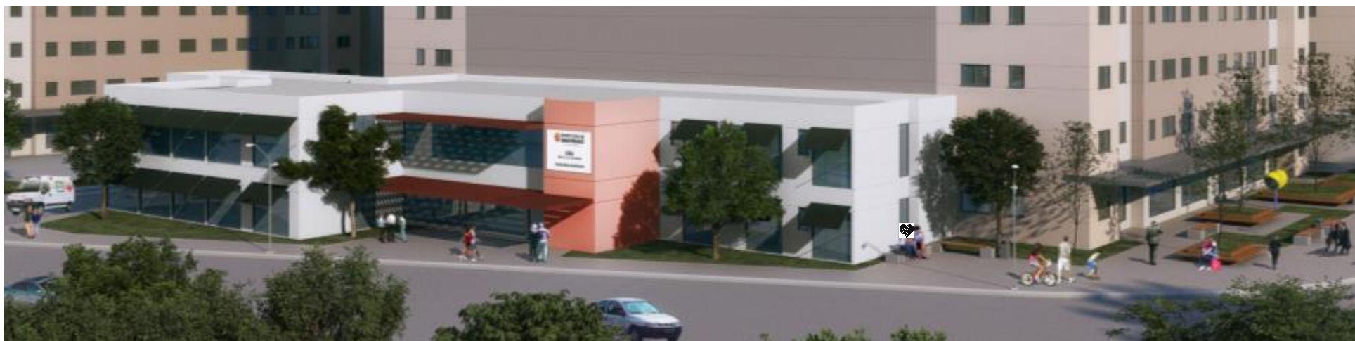
UBS – entregue construída
